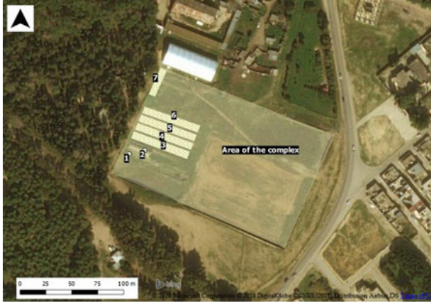
الشكل 6. سبعة صهاريج كبيرة والمجمع الضخم جنوب شرق قورينى (المؤلف).
